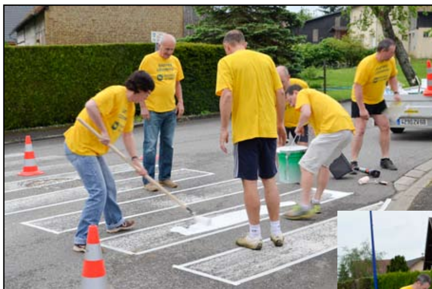
Traçage des passages pour piétons
