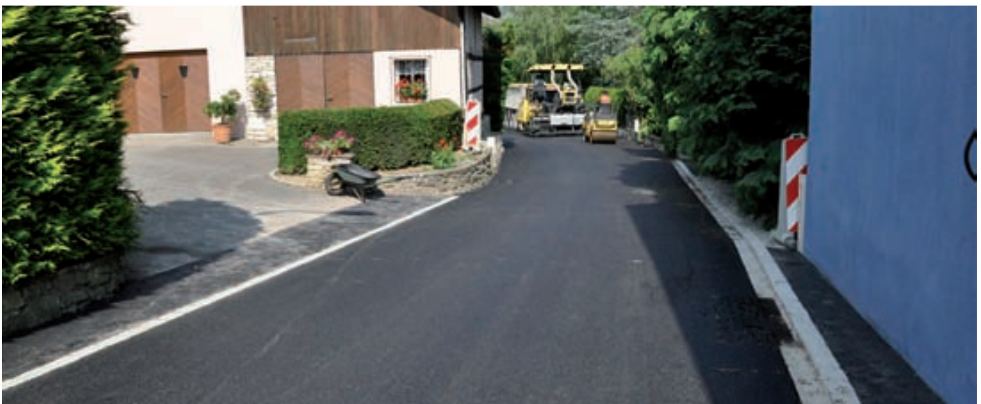
La pose des enrobés marque également la fin d'un long chantier dans la rue de la forge
