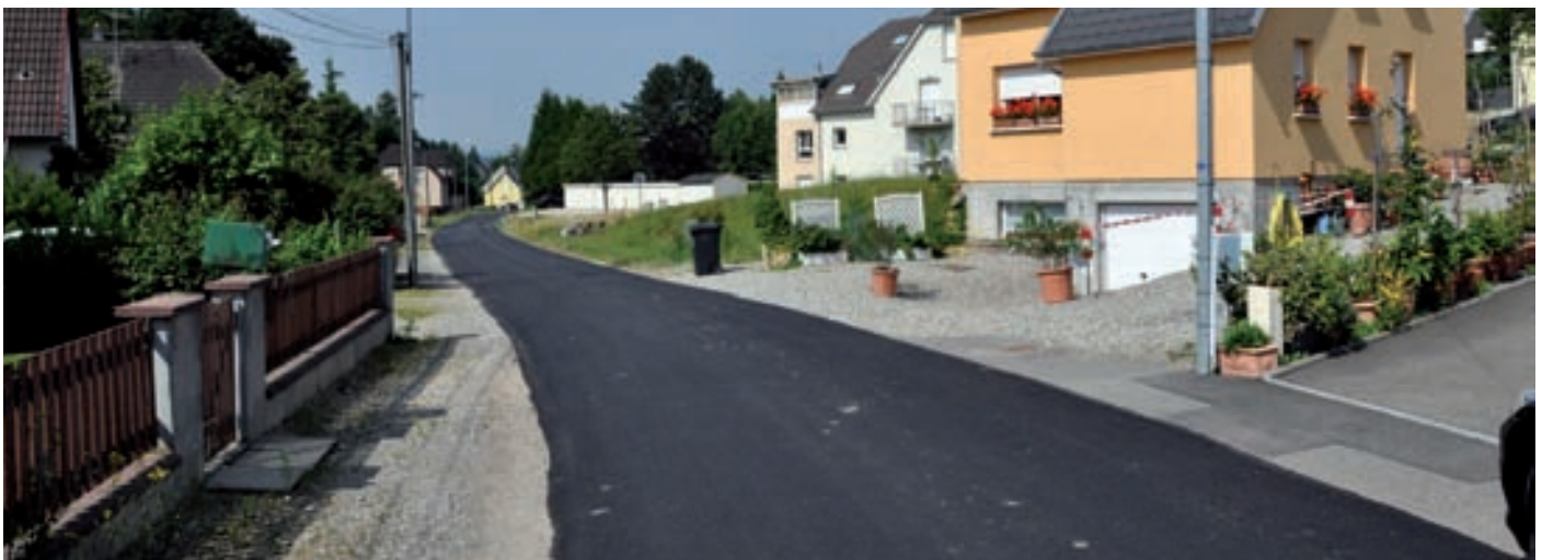
La couche de roulement a été refaite provisoirement dans la rue de la vallée, en attendant les travaux d'assainissement
