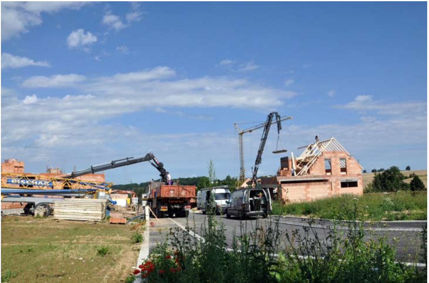
Les grues ont pris possession du lotissement du Clos des vergers
